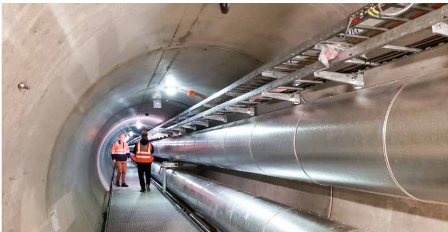
2 Stollen für die Verbindung der Fernwärmeversorgungsgebiete in Zürich-Nord und Zürich-West.
