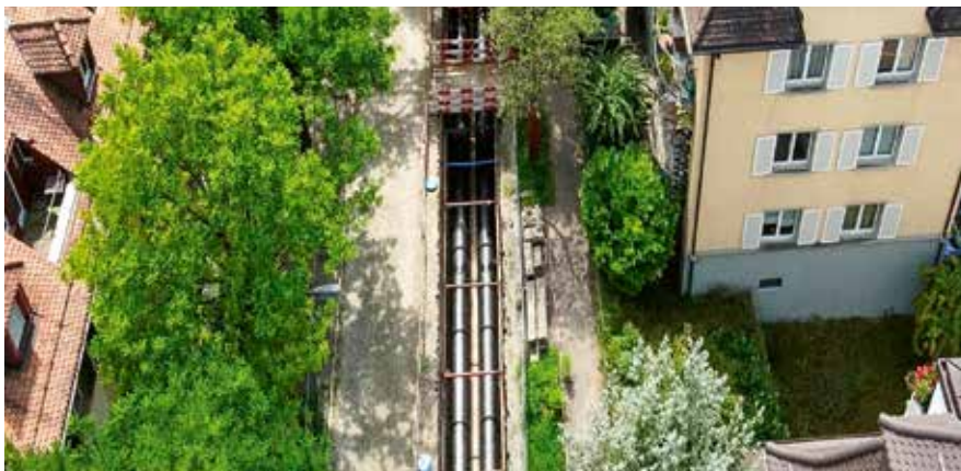
2 Die Feinverteilung der klimafreundlichen Fernwärme kommt voran.
