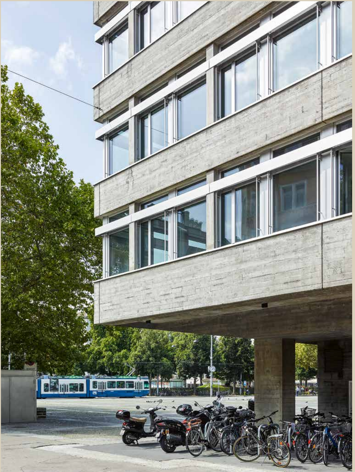
1 Das Erhalten und Instandsetzen der eigenen Immobilien und Zweckbauten ist eine wichtige Aufgabe für das städtische Hochbaudepartement; entsprechend wird eine dauerhafte Nutzung angestrebt (im Bild: Amtshaus Helvetiaplatz, Instandsetzung 2019, Kaufmann Widrig Architekten).
