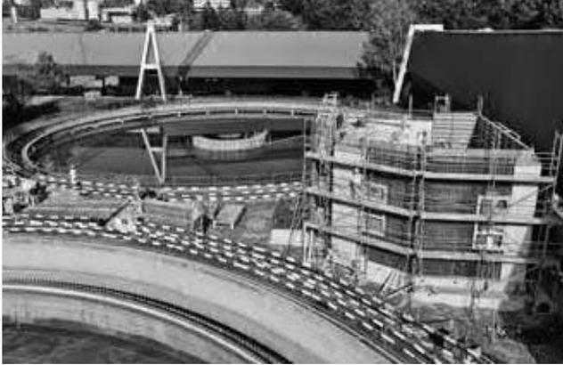
Damit sich der Überschussschlamm in den Vorklärbecken besser absetzen kann, wird auch eine neue Dosierstelle für Flockungshilfsmittel gebaut. (Bild: ERZ)
