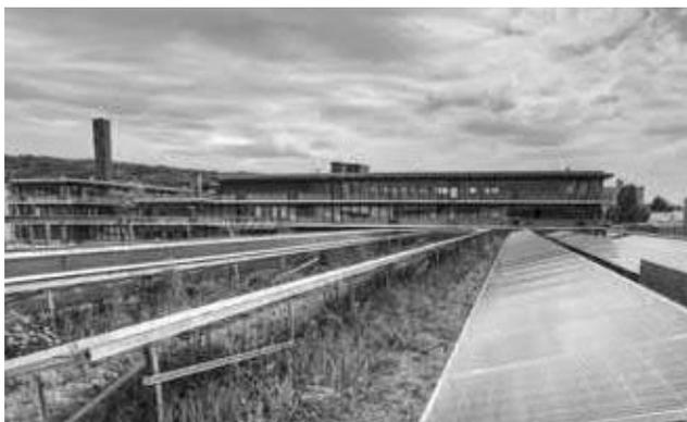
Gut kombiniert, kann Dachbegrünung eine Photovoltaik-Anlage kühlen und damit deren Wirkungsgrad erhöhen. (Bild: ewz)
