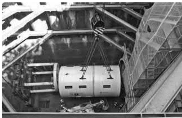
Für den Bau der Verbindungsleitung wurde im Juli eine 100t schwere Tunnelbohrmaschine in den 20m unter Tag liegenden Schacht Milchbuck eingebracht. (Bild: ERZ)
