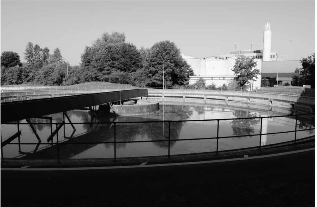
Die hohe Reinigungsqualität des Wassers wird dank vier Reinigungsstufen erreicht: mechanische, biologische und chemische Reinigung und anschliessende Filtration. (Bild: ERZ Werdhölzli)
