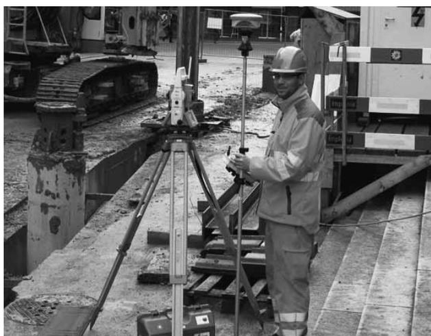
Kombination Messmethoden Tachymeter und GPS. (Foto: GeoZ)
