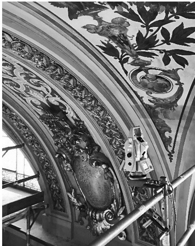
Baustelle Kongresshaus: Einsatz einer Totalstation. (Bild: GeoZ)
