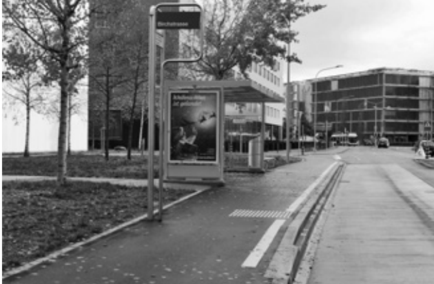
Die hindernisfrei umgestaltete Bushaltestelle «Birchstrasse» mit dem «Züri-Bord» an der Binzmühlestrasse in Neu-Oerlikon. (Bild: Sabina Mächler, TAZ)
