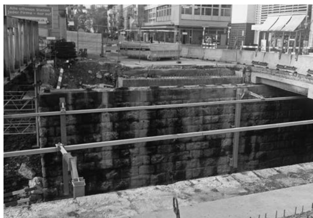
Die Sanierungsarbeiten an der Nordbrücke kommen planmässig voran. (Bild: TAZ)
