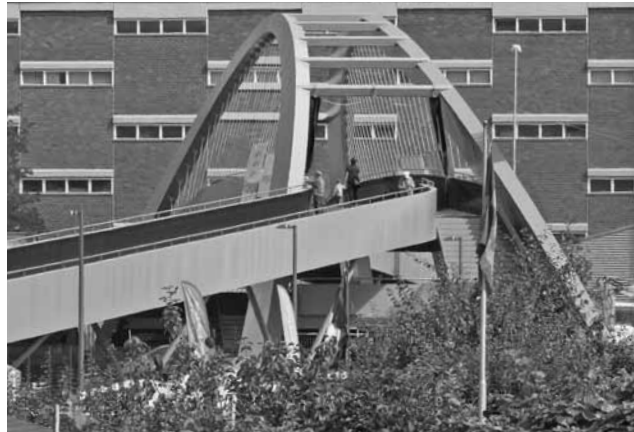
Der Gleisbogen schwingt sich in Form einer markanten Passerelle über die Pflingstweidstrasse. (Bild GSZ)
