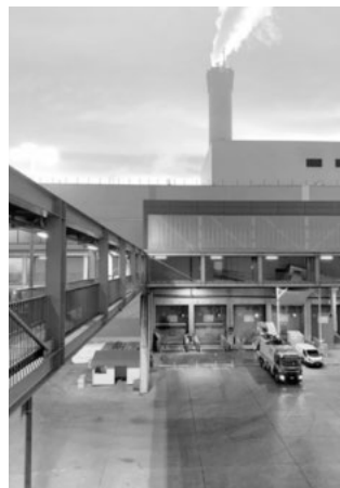
Abwasser und Rauchgase aus dem Kehrichtheizkraftwerk Hagenholz werden nach gesetzlich vorgegebenen Standards gründlich gereinigt. (Bild: ERZ)
