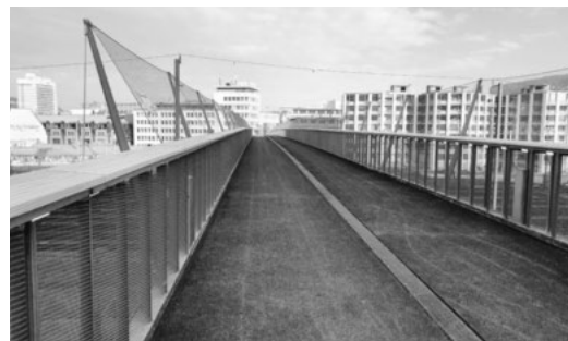
Die neue Fussgängerüberführung ermöglicht eine kurze und sichere Querung des Gleisfelds zwischen den Stadtkreisen 4 und 5. (Bild: SBB)
