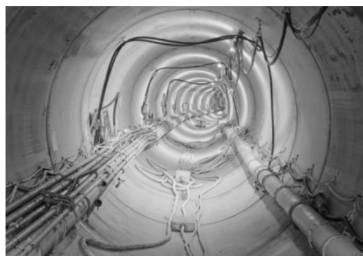
Der Microtunnel verbindet den Schacht Gerstenstrasse mit der Kaverne Strickhof, unterquert die Limmat und ist insgesamt 2,4 km lang. (Bild: Gerry Pacher, Euthal)
