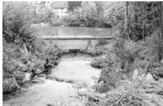
Den Höhenunterschied der Limmat überwinden die Fische, indem sie von einem Becken in das nächsthöher gelegene gelangen. (Bild: ERZ)
