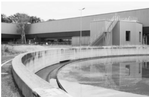
Damit sich der Überschussschlamm in den Vorklärbecken besser absetzen kann, wird ihm bei Bedarf Flockungsmittel zugesetzt. (Bild: ERZ)
