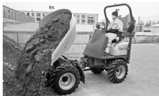
Auf dem Werkhof Nord kommt seit 2020 ein elektrisch angetriebener Dumper zur Beförderung von Baumaterial zum Einsatz. (Bild: TAZ)
