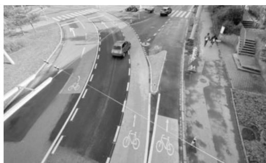
Durch die bauliche Anpassung des Abbiegewinkels in die Bucheggstrasse konnte die Stadt Zürich den Unfallherd beim Bucheggplatz beheben. (Bild: DAV)
