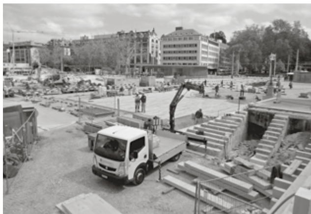
Grossbaustelle Sechseläutenplatz: Über 12 000 m 2 Naturstein wurden auf dem grössten innerstädtischen Platz der Schweiz verbaut. (Bild: TAZ)
